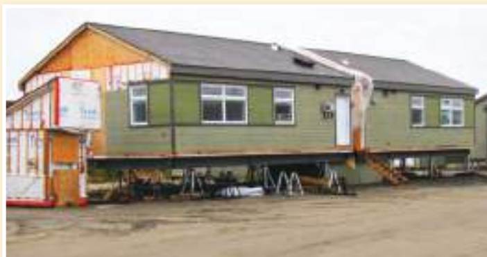
Maisons jumelées en construction, Kuujuaq, 2010.
